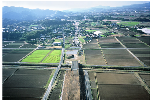
写真2 国道270号（宮崎バイパス）上空写真
