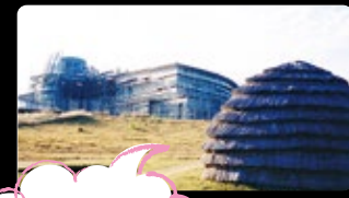
着々と完成に 近づいています
