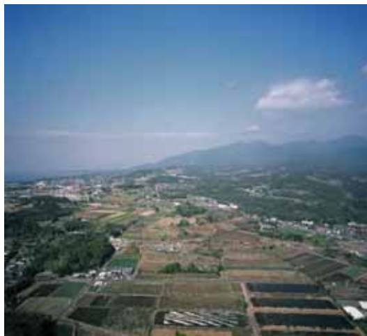
写真 1 古江バイパス全景(南から)
