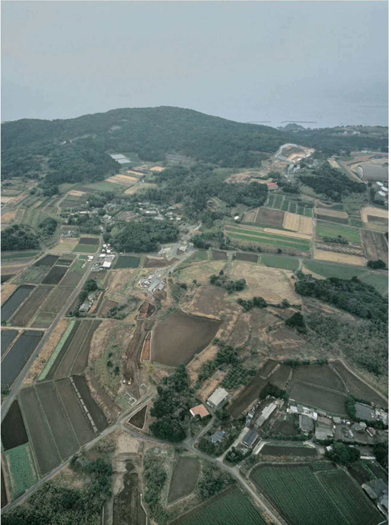
R4年度調査 萩ヶ峰・白水B・山ノ上A遺跡全景（西から）
