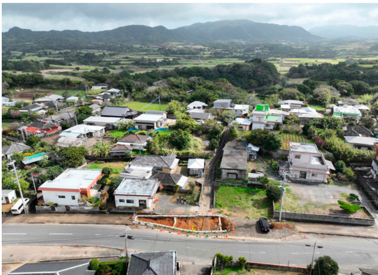
②空撮（西から東を見る）
