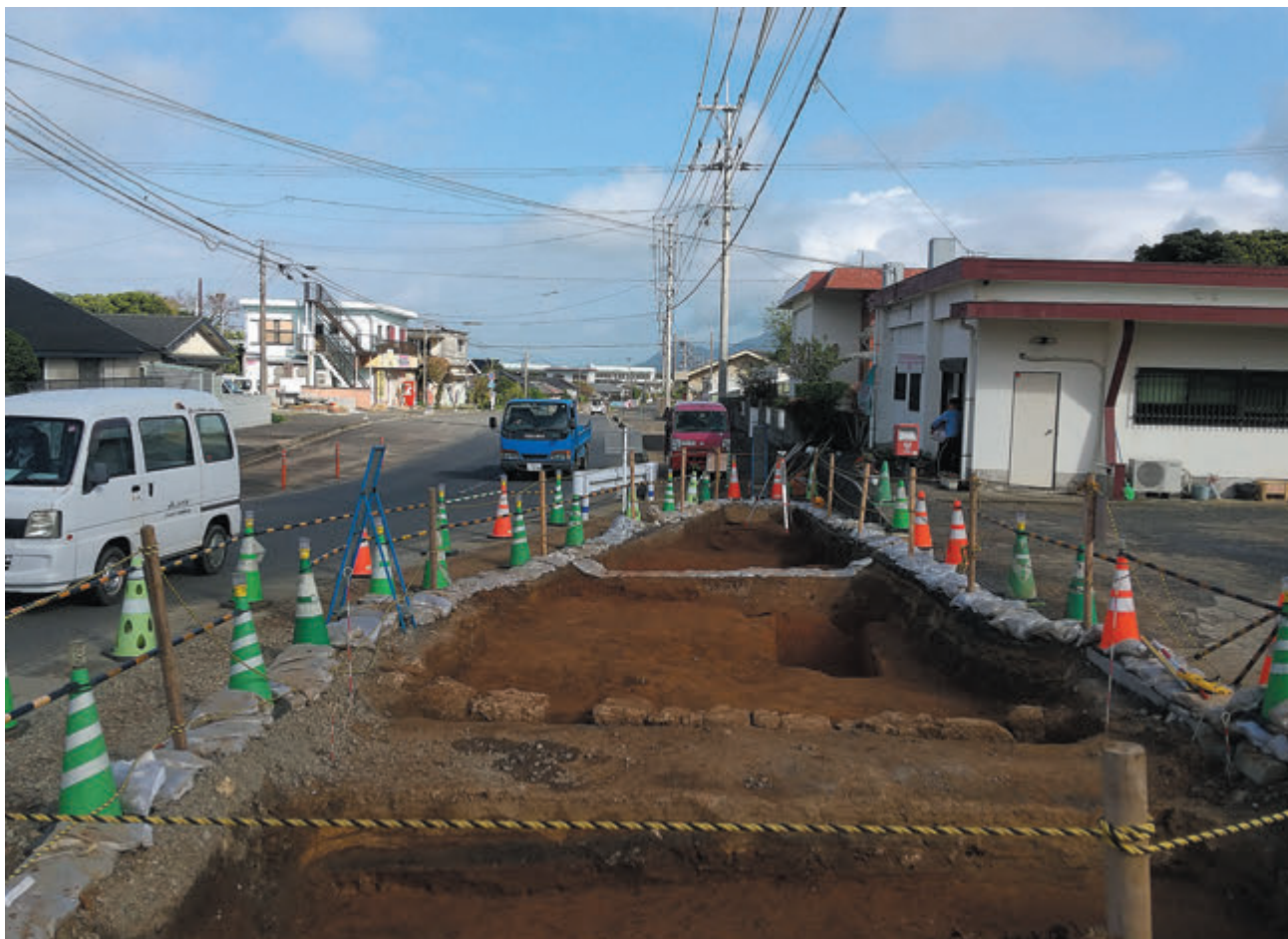
④作業風景 4
