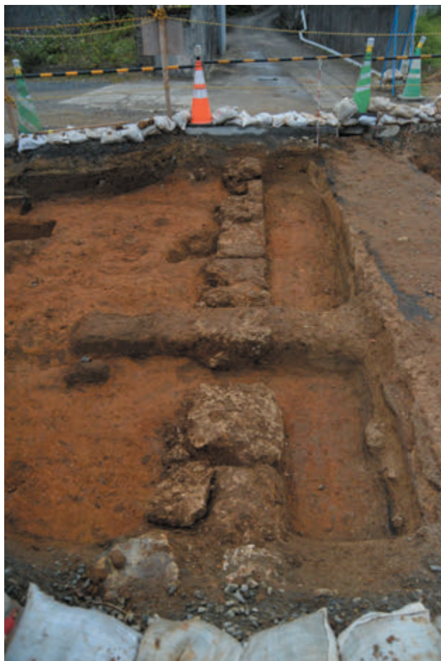
①石垣検出状況 1
