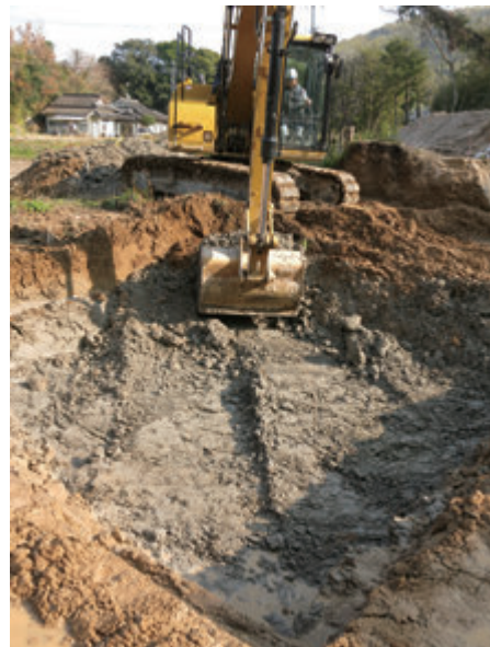
写真21 造成土除去作業風景
