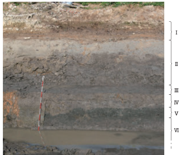
3トレンチ土層写真
